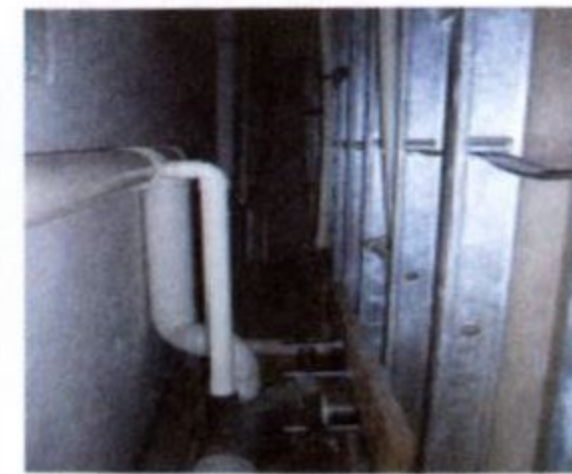
检修夹墙内管线布置
