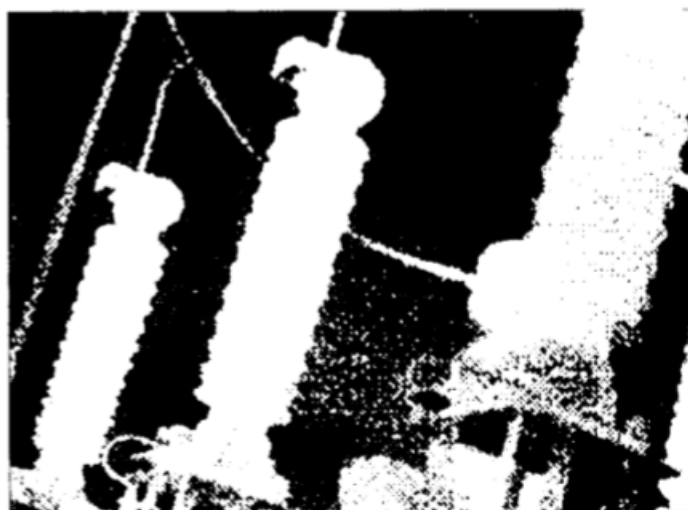
图 J. 19 110kV 氧化锌避雷器发热
