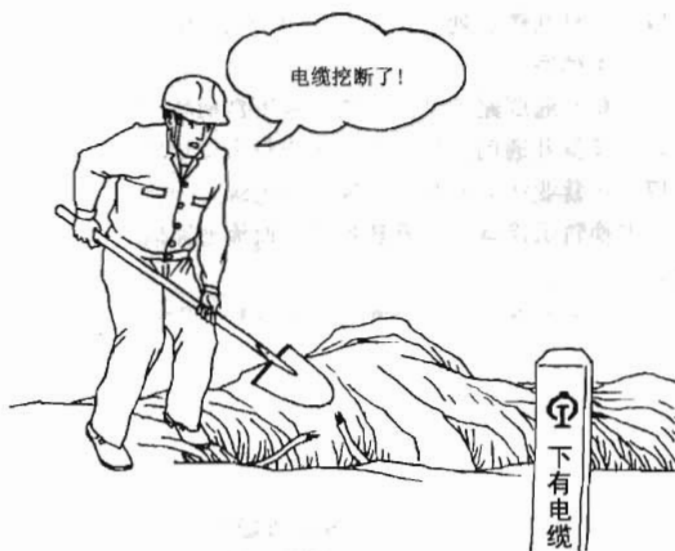
图 4.1.1 挖沟前未调查地下设施造成电缆被挖断
