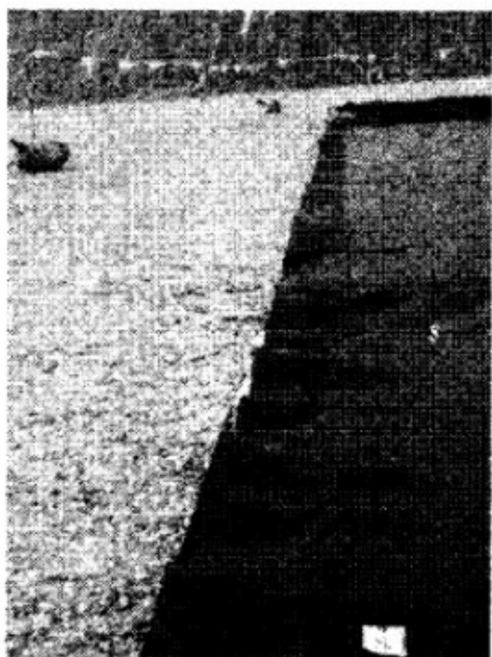
图 4-4 复合土工膜皱边现象
