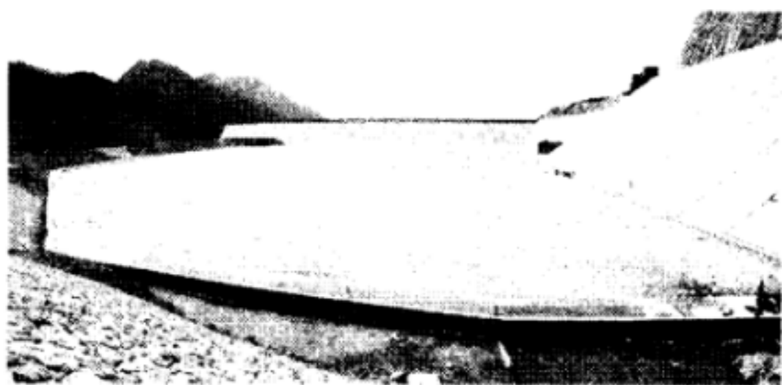
图 5-1 泰安蓄能上水库土工膜 防渗区蓄水前
