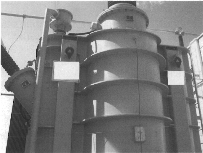
图 C.3 传感器布置区域（高压出线端子附近）
